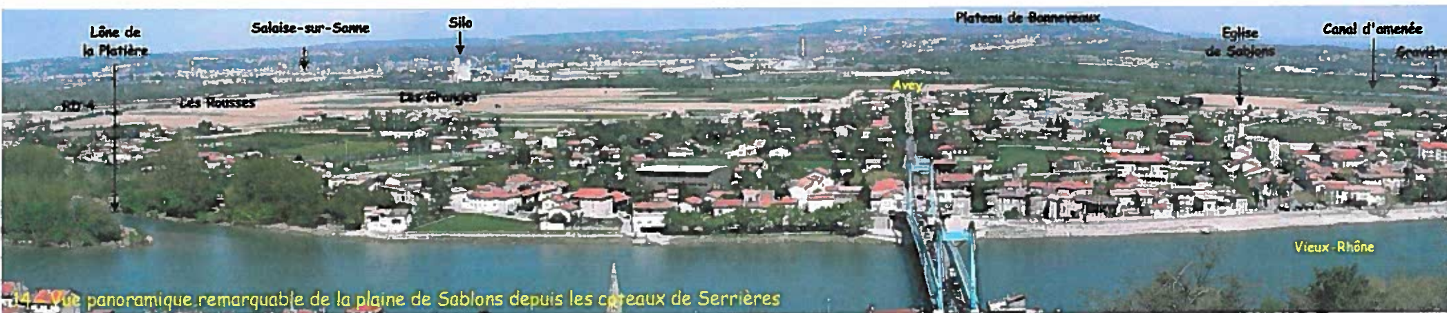
13 - Façade fluviale en aval de Sablons
